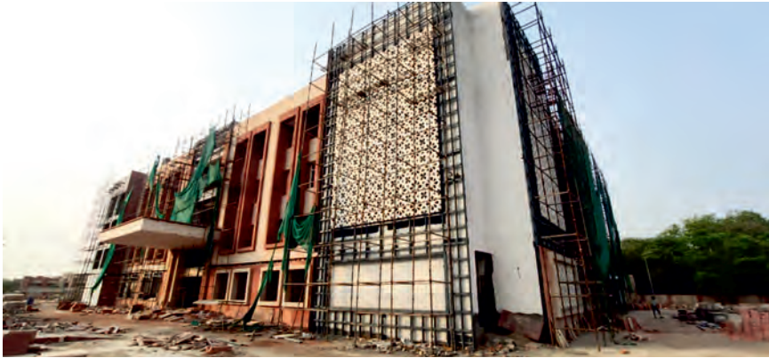
नए कार्यालय भवन का निर्माण कार्य
